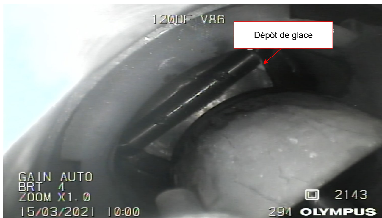
Figure 103 : Amorce du phénomène de givrage => instant désigné t_0
