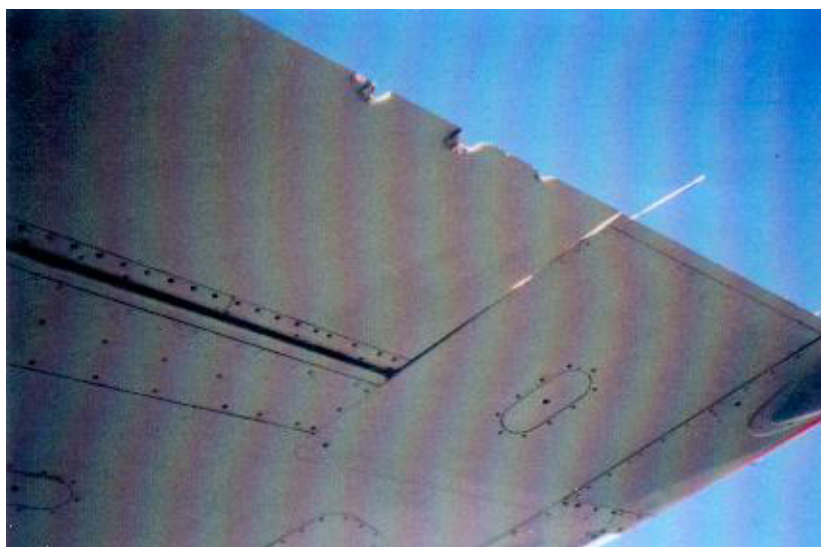
Aileron basse vitesse, aile droite Traces laissées par les câbles
