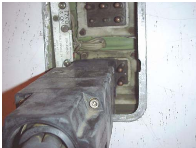
Exemple de branchement incorrect (source Boeing)
