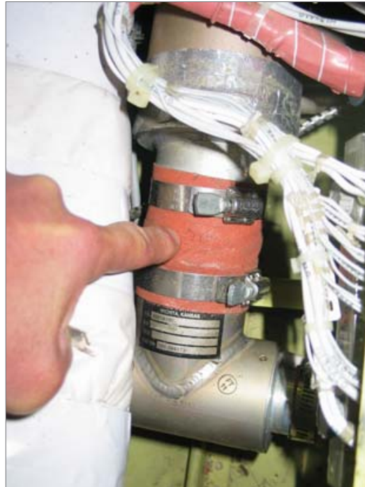
Figure 4 : les mêmes équipements après retrait de l'isolation thermique
