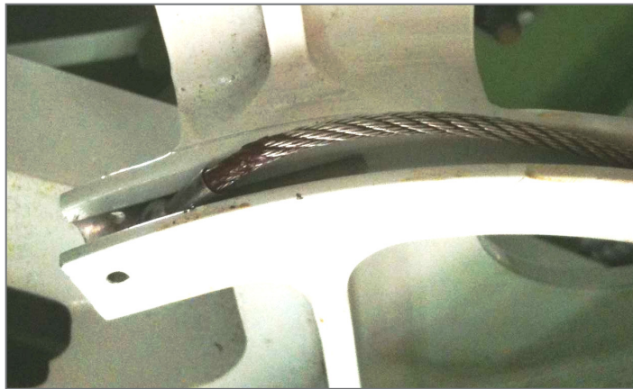
Exemple de mauvais montage
