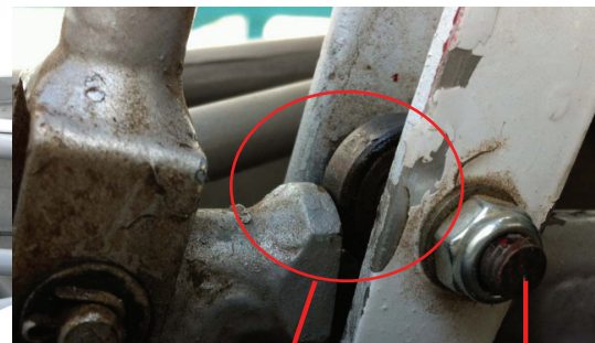
Galet en position anormalement haute dans son logement
