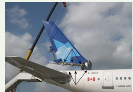
Dépose de la dérive et vue de l'emplacement des raccords de fixation principale.
