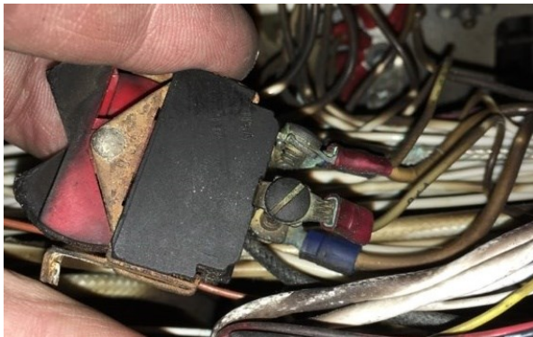
Conducteurs connectés au Master Switch , situés derrière la planche de bord
