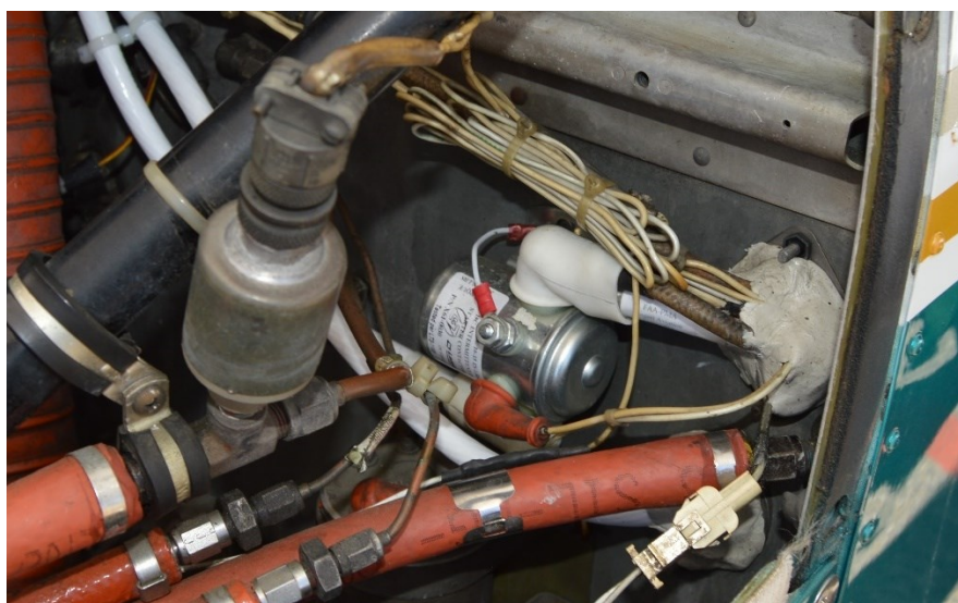
Figure 153 : Starter Solenoid en position dans le compartiment moteur, sur la cloison pare-feu Source : BEA
