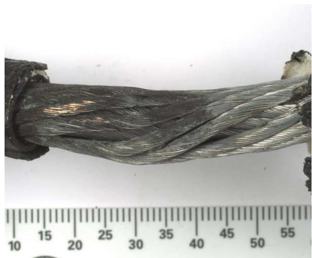
Figure 68 : Déformation des torons composant le conducteur Source : BEA
