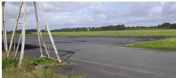
Aire de stationnement liée à la voie de circulation A et début de la voie de service avec le pylône métallique
