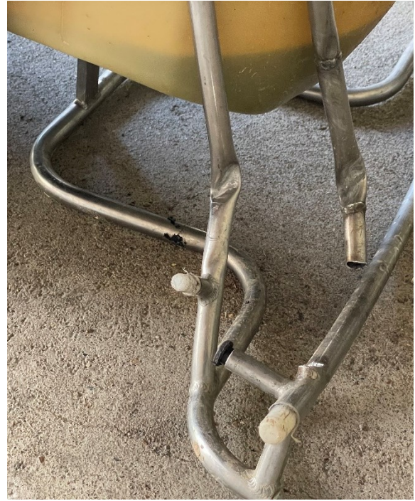
Figure 3 : marques du contact du châssis du paramoteur avec un des câbles de la ligne électrique (Source : BEA)
