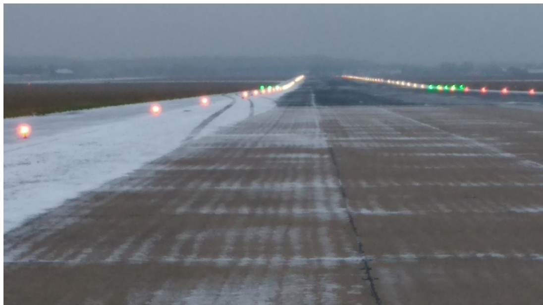
Figure 3 : Photo prise peu après l'incident, dans le sens de l'atterrissage, environ 600 m avant le seuil de la piste 25 et montrant l'état de surface de la piste en amont du seuil décalé ainsi que les traces laissées par les roues de l'avion lors de la sortie latérale de piste
