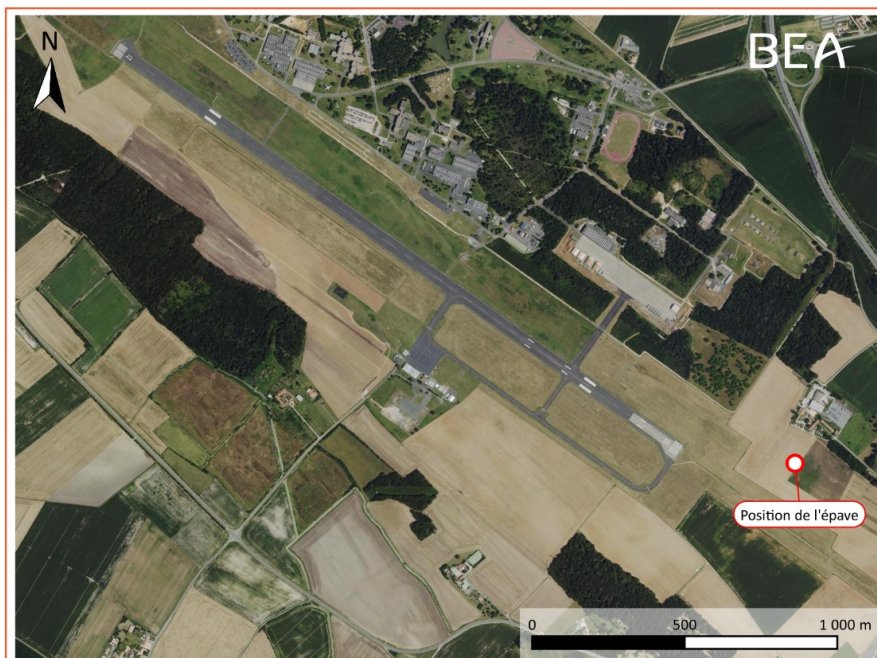
Figure 2 : position de l'épave à l'est de l'aérodrome (Source : IGN, annotations BEA)
