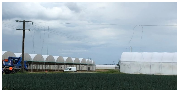
Figure 4 : poteau de dérivation et câbles sectionnés (Source : BEA)
