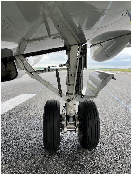
Figure 2 : train principal gauche du F-HBXI après l'atterrissage, vue de l'avant vers l'arrière (Source : BEA)
