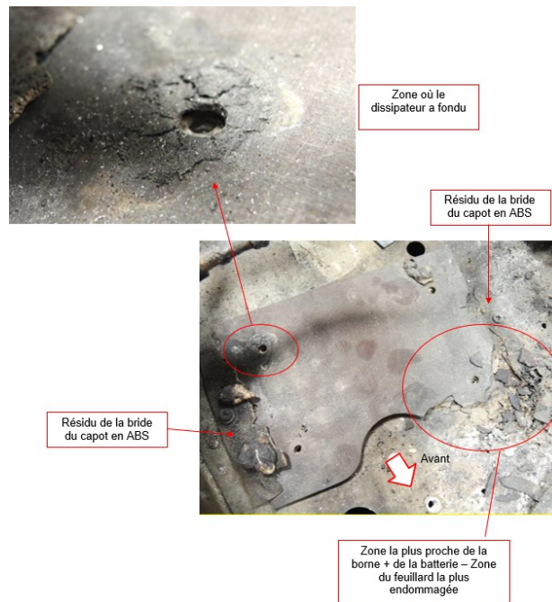
Figure 11 : feuillard phénolique sur le plancher de l'avion (Source : BEA)
